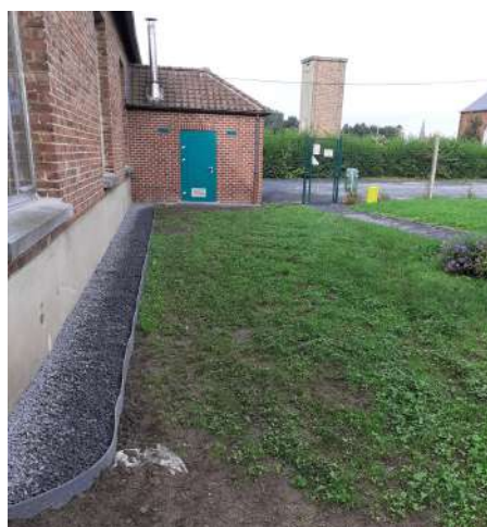
Ecole de Sars-la-Buissière - placement d'un drain
