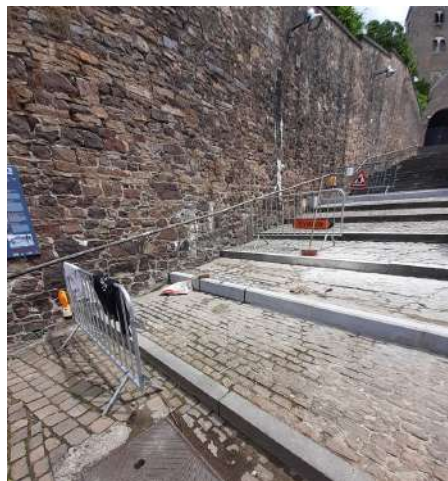
Réparation des marches des escaliers de la Collégiale
