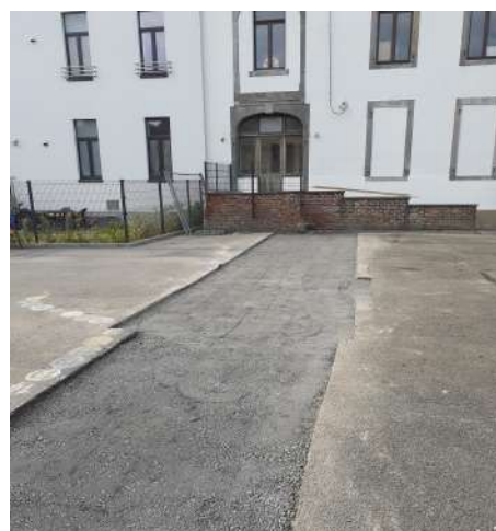
Ecole de Sars-la-Buissière - réfection du revêtement d'une partie de la cour
