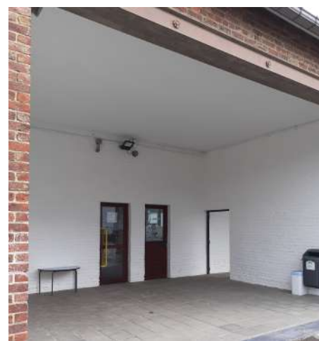
Ecole de Sars-la-Buissière - mise en peinture des préaux de la cour
