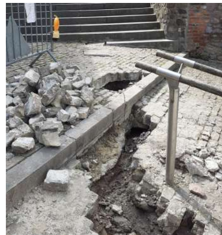
Réparation d'un caniveau dans les escaliers de la Collégiale
