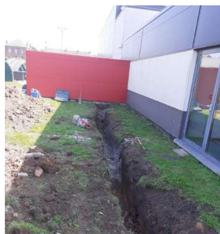
"Le Scavin" - raccordement en eau et électricité du terrain de tennis
