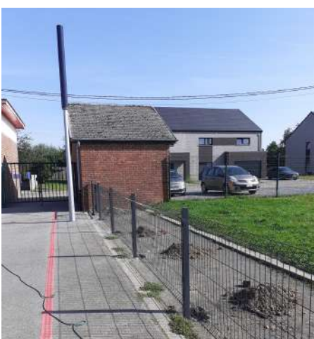
Ecole de Lobbes Bonniers - pose d'une clôture et de luminaires leds
