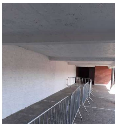
Ecole de Lobbes Bonniers - mise en peinture des corniches
