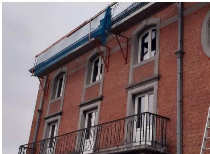
Salon communal - intervention sur la toiture et les corniches
