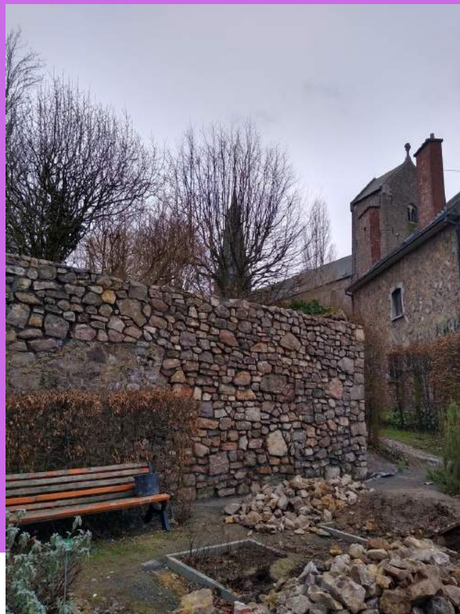
Jardin de Folcuin - réfection du mur
