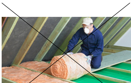
Isolément des combles par laine de verre
