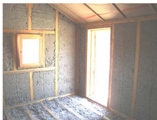
Isolément des combles par ouate de cellulose
